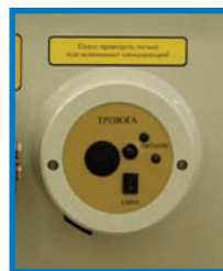
Система аварийной сигнализации позволяет пациенту обратить внимание врача на нештатную ситуацию
